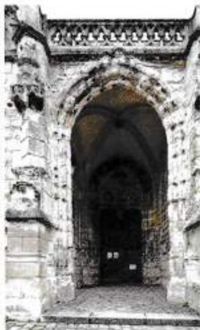
Vue du bras Sud du transept en 1935. La voûte qui se déverse vers le Sud est épaulée par d'imposantes contrefiches jusqu'au sol. (MAP)
