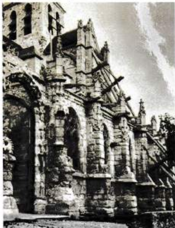
Vue du bras Sud du transept en 1935. La voûte qui se déverse vers le Sud est épaulée par d'imposantes contrefiches jusqu'au sol. (MAP)
